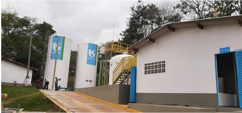
Figura 51: Vista geral da ETA.
