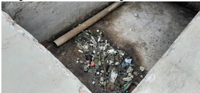
Figura 54: Sólidos retidos no gradeamento – ETE.
