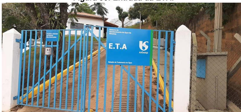
Figura 50: Entrada da ETA.
