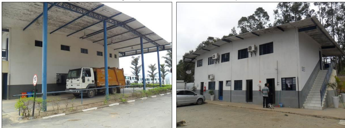
Figura 35: Balança e prédio administrativo, respectivamente.
