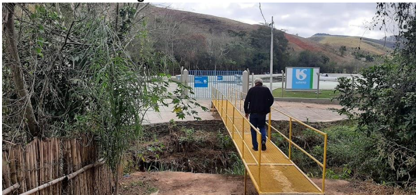
Figura 52: Entrada da ETE.
