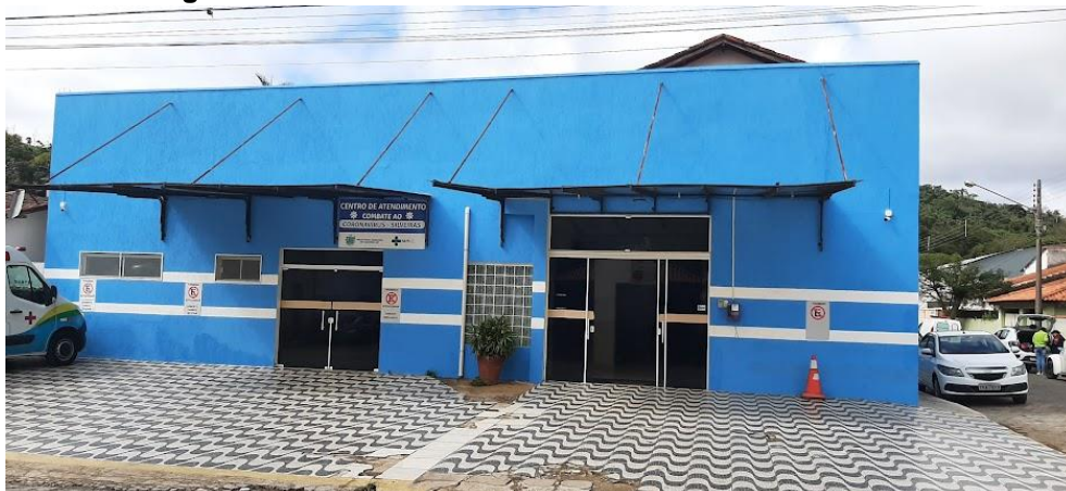
Figura 39: Vista externa da Unidade Mista de Saúde.
