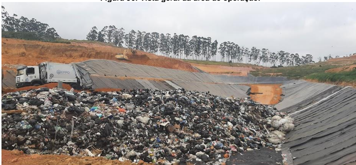
Figura 36: Vista geral da área de operação.
