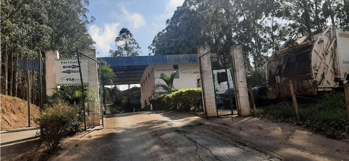
Figura 57: Vista geral da entrada do empreendimento VSA Soluções Ambientais.
