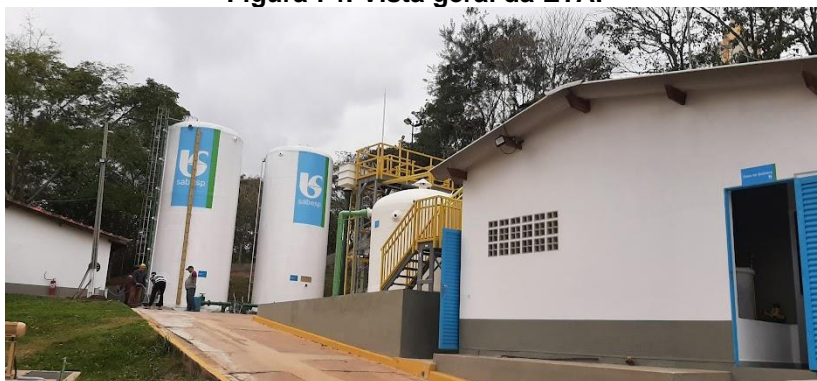
Figura 74: Vista geral da ETA.
