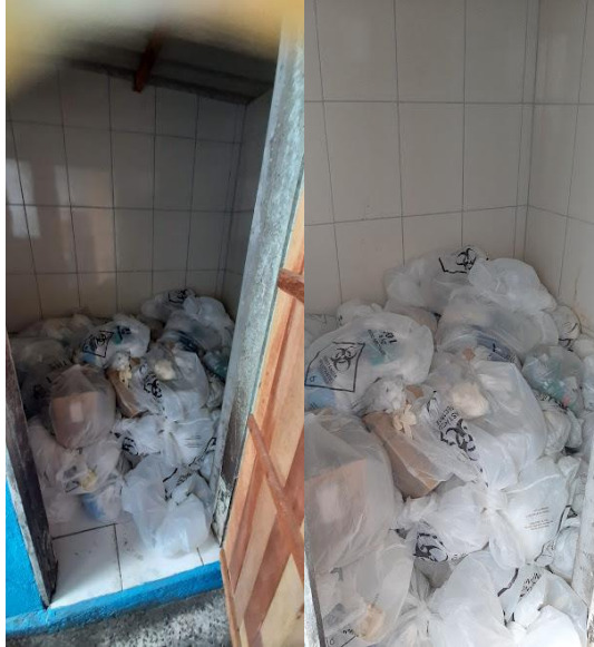
Figura 65: Abrigo externo de RSS – Vista Interna.
