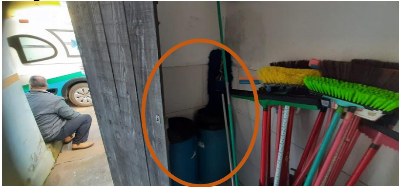
Figura 70: Local de armazenamento dos RSS – bombonas.
