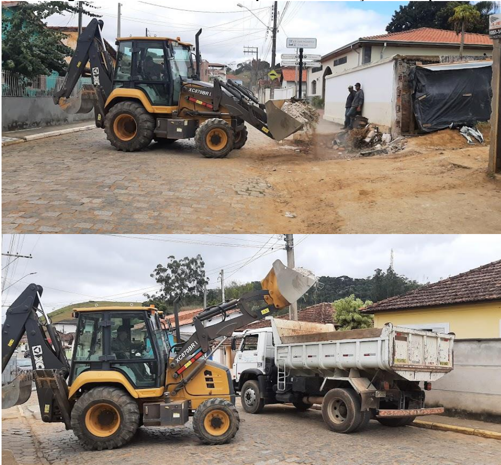
Figura 54: Retirada de entulho pela Administração Municipal.
