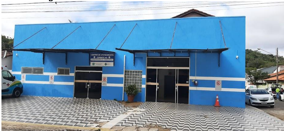
Figura 62: Vista externa da Unidade Mista de Saúde.
