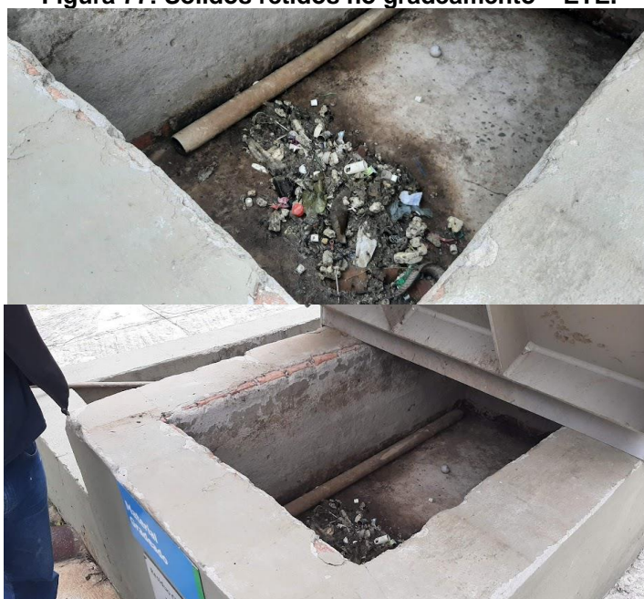
Figura 77: Sólidos retidos no gradeamento – ETE.
