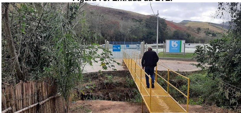
Figura 75: Entrada da ETE.
