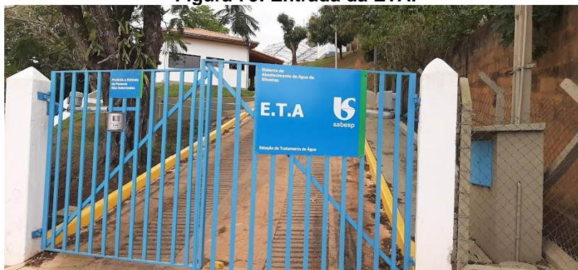
Figura 73: Entrada da ETA.
